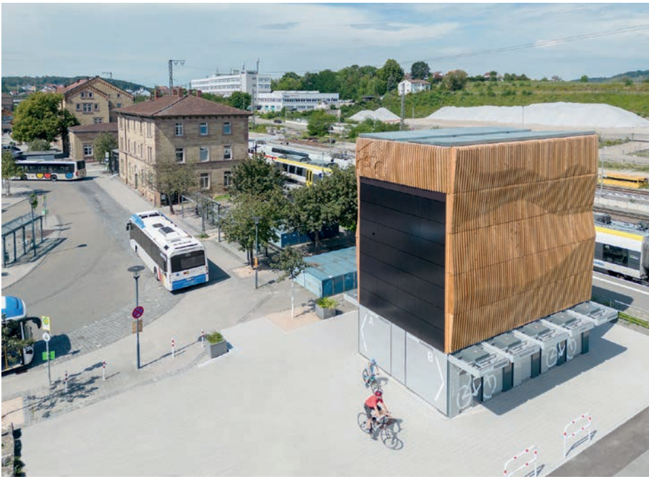
Fahrradparkanlage Mühlacker für 120 Fahrräder mit integrierter Photovoltaik-Anlage
